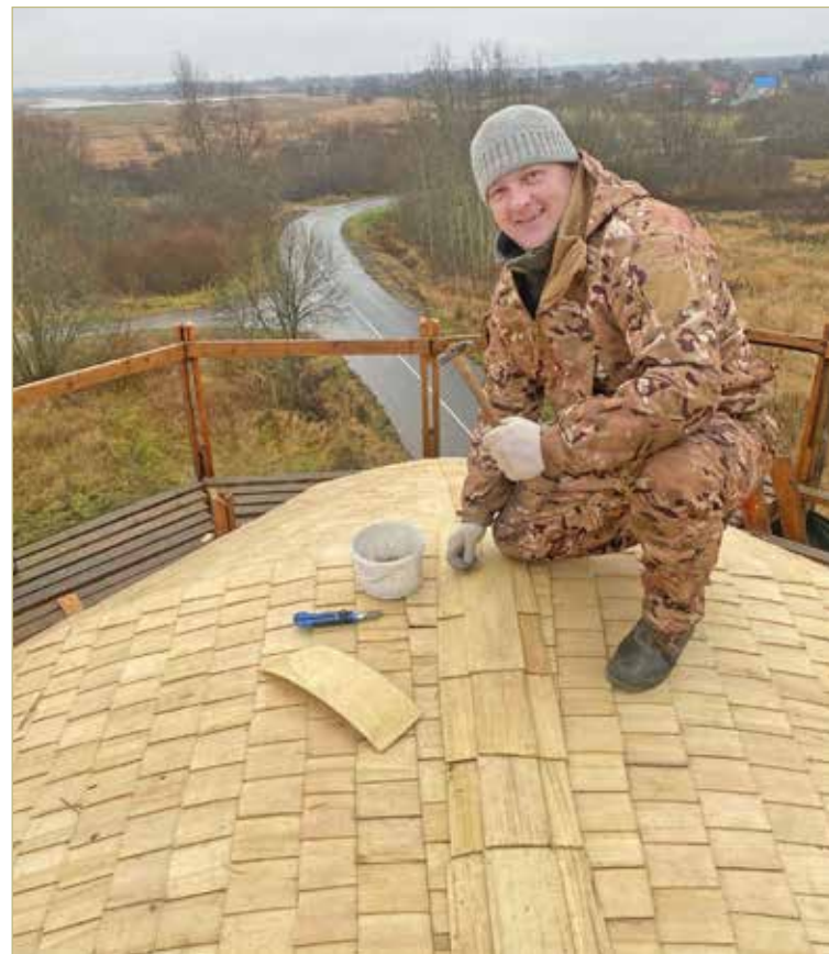
Шатёр мельницы, как и её стены, покрыли осиновою дранкой.
